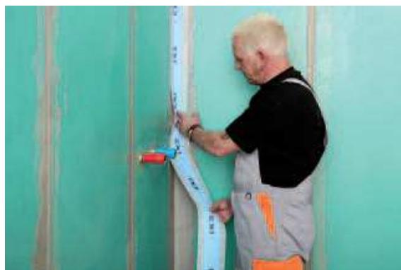
PCI® Pecitape накладывается на свеженанесённый слой гидроизоляции.
